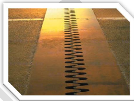
Gambar 5.13 (a) Pemuaian pada jembatan (Sumber. Ewen, D., Schurter, N., & Gundersen, P. E.,2012).
