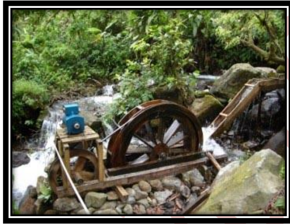
Gambar 16.12 Pembangkit listrik tenaga air
