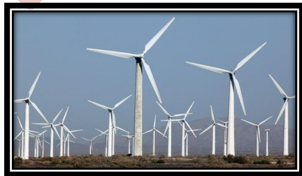
Gambar 16.13 Pembangkit listrik tenaga angin
