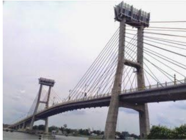
Gambar 3. Jembatan Nasional Suromadu dengan bahan kabel penahan dengan elastisitas besar.
